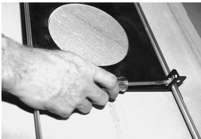
Рисунок 9.3: Затягивание крепежных винтов кронштейна
